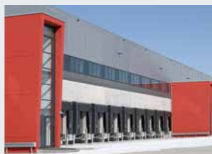
Immogate – logistické centrum, Mníchov
